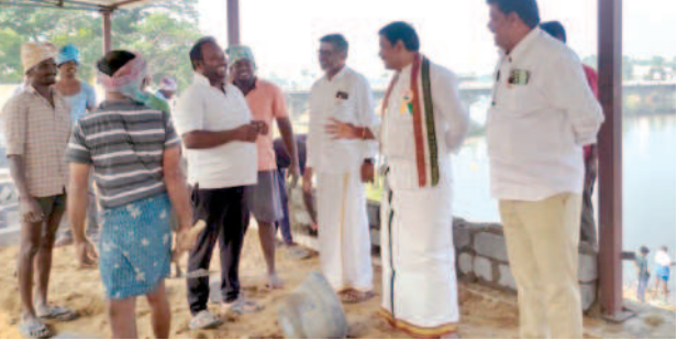
మరుగుదొడ్ల నిర్మాణాలను పరిశీలిస్తున్న చైర్మన్ లంజారు తారక శ్రీనివాసులు
